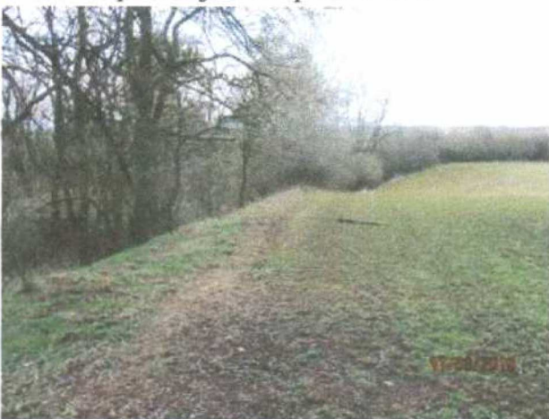
pohled severozápadní na parc.č. 1757
