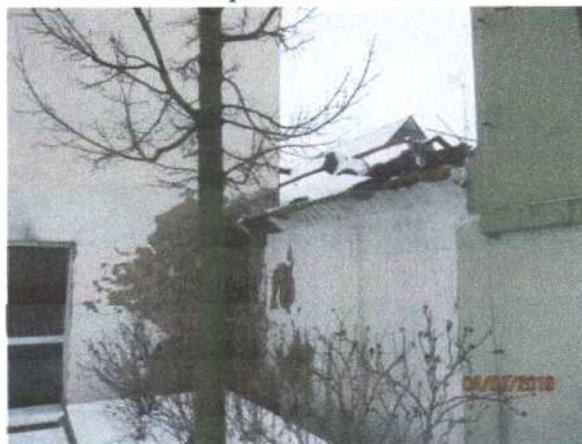
Provlhlé zdivo od sousedního objektu
