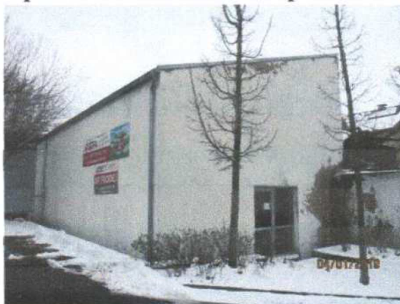
Čelní pohled na stavbu
