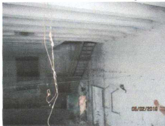
Interiér 1.PP se schodištěm do 2.NP
