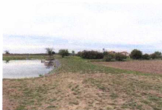
Nad p.č. 2270 je retenční nádrž
